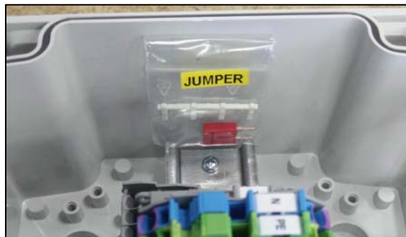
Перемычка и заглушка в электромонтажной коробке
