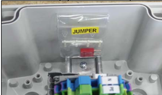
Pribalený mostík a záslepka v rozvodnej krabici
